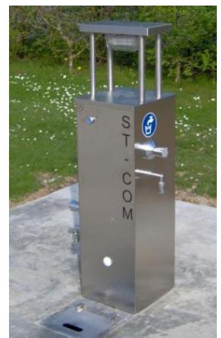
Beispiel Hinweisschild an Frischwasservorrichtung
